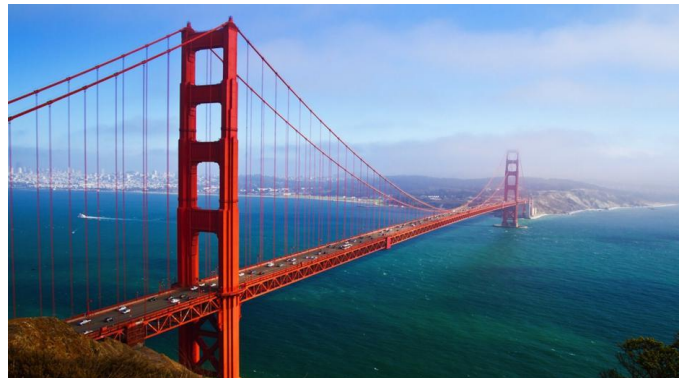
Golden Gate Bridge à San Francisco
