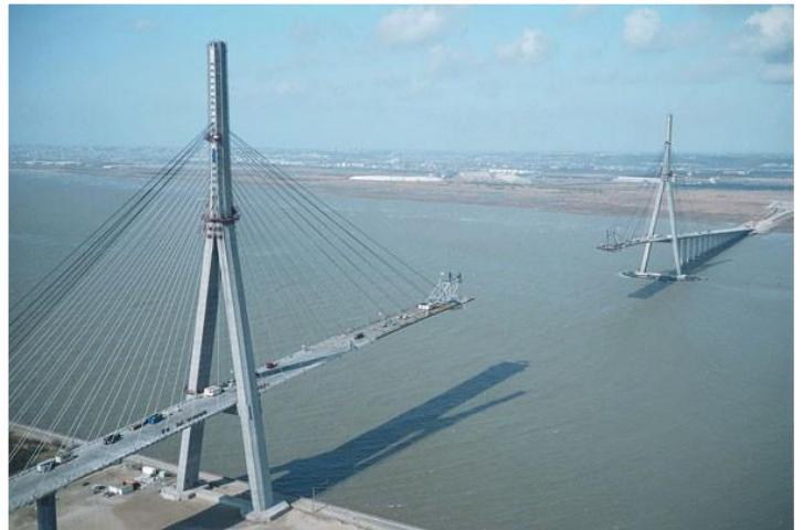
Construction du pont de NORMANDIE
